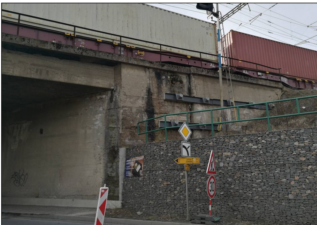
Obr. č. 9 - pohled na opěru Č. Třebová - pohled na táhla spojující opěru s křídlem
