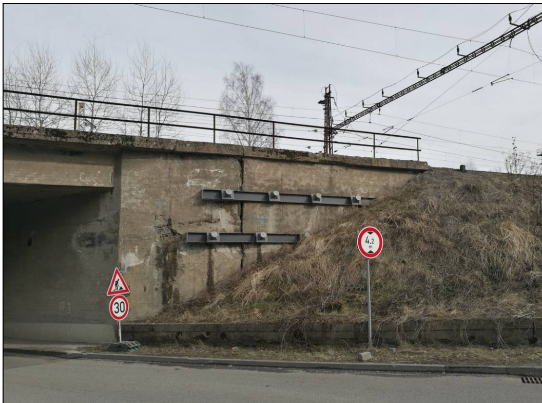
Obr. č. 8 - pohled na opěru Svitavy - pohled na táhla spojující opěru s křídlem
