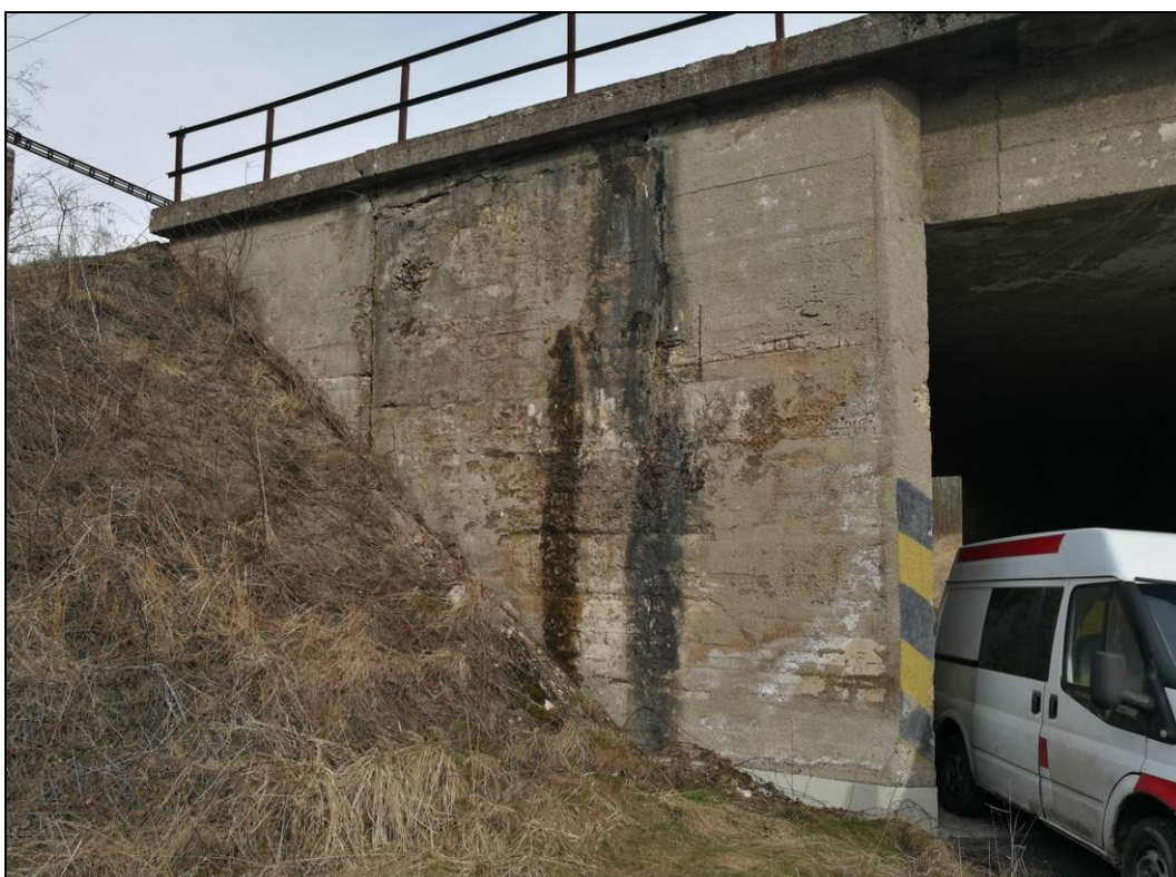
Obr. č. 7 - pohled na opěru Č. Třebová zleva - degradovaný beton v líci
