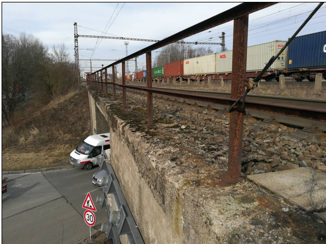
Obr. č. 10 - pohled na římsu a zábradlí s celoplošnou povrchovou korozí
